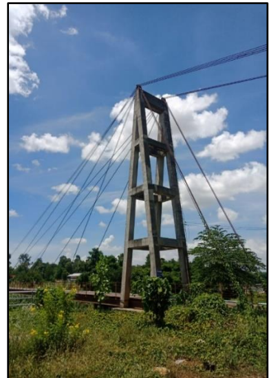
สะพานสลิ้ง
