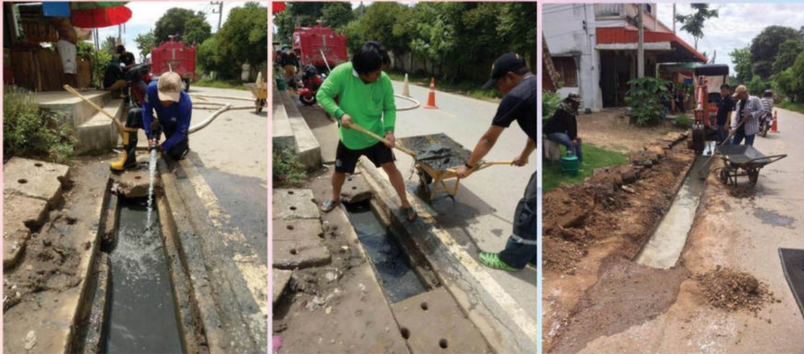
ลอกทรายระบายน้ำที่อุดตัน หรือน้ำท่วมขัง
