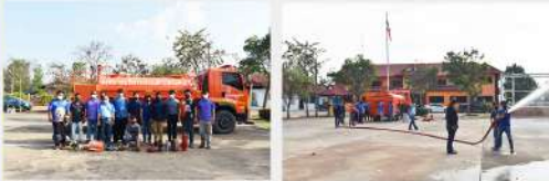
เป่าท่อประปาอุดตันหมู่ที่ 9
