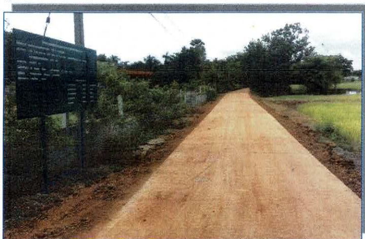
รูปแล้วเสร็จ
