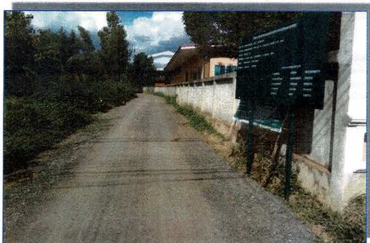
รูปแล้วเสร็จ
