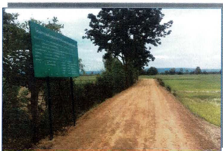
รูปแล้วเสร็จ
