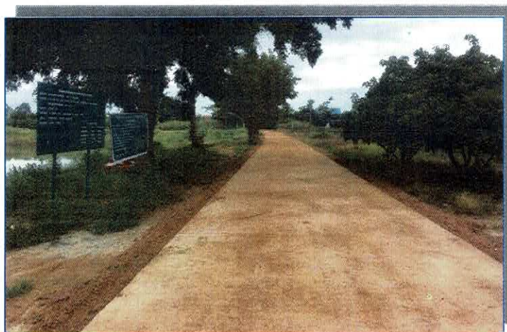
รูปแล้วเสร็จ
