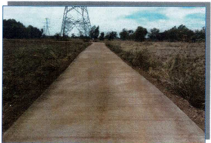
รูปแล้วเสร็จ
