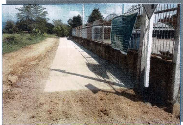
รูปแล้วเสร็จ
